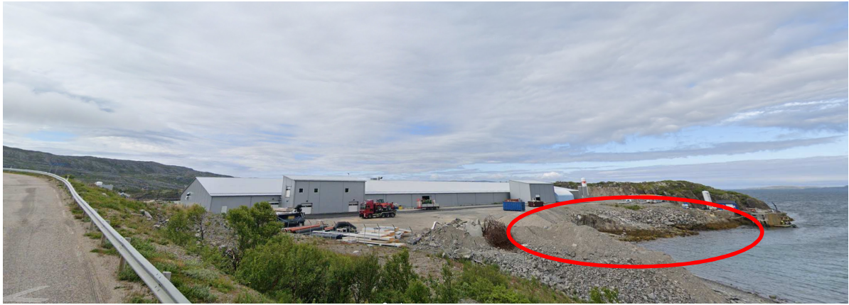
Figur 14 Eksisterende anlegg sett fra Fv, fra SV mot NV. Rød sirkel viser nytt utfyllingsområde.
