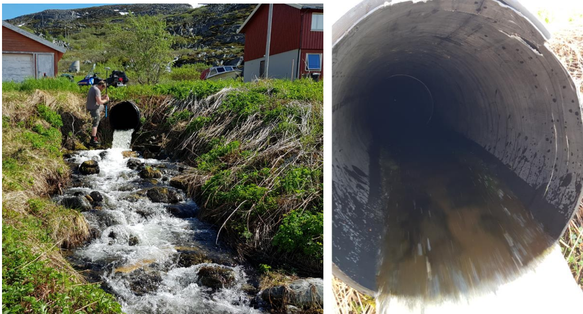
Bilde 4-2. Bilder tatt mot utløpet til bekkelukkingen. Kilde: Rambøll v/TUPH 12.06.2012.
