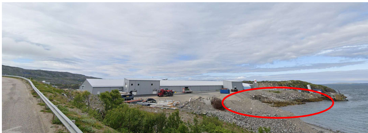
Figur 14 Eksisterende anlegg sett fra Fv, fra SV mot NV. Rød sirkel viser nytt utfyllingsområde.
